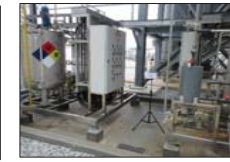
Chemical Dosing HRSG
